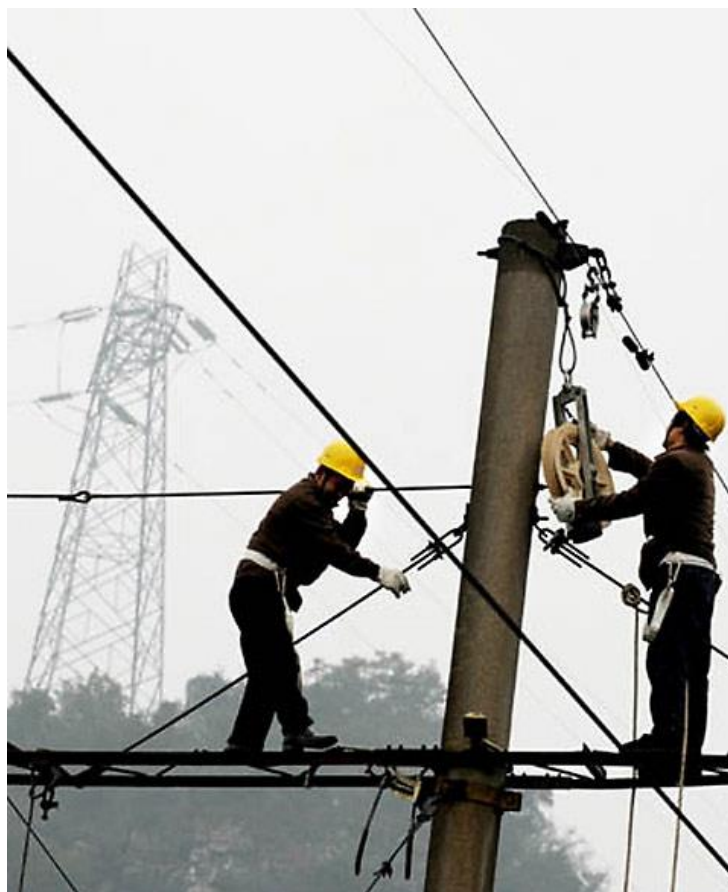
Рисунок 3 – Работы по техническому обслуживанию ВЛИ
