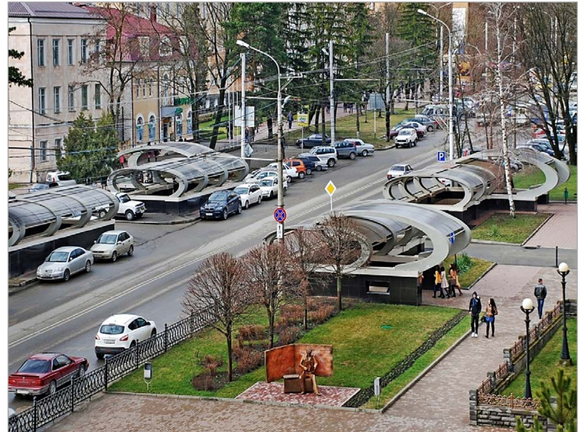
Подземный переход, 2019 год
